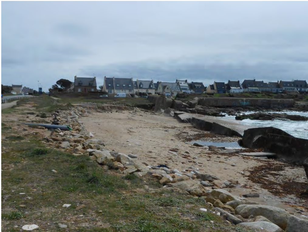
Illustration 12 : Enrochement au plus près de la route au Sud de l'anse du Courégant (photo : BRGM, avril 2018)
